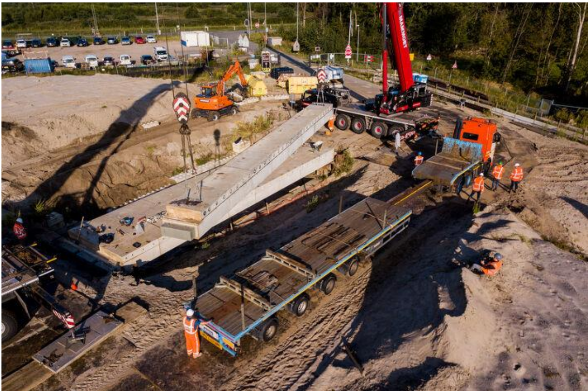
Figuur 4: Montage van het circulaire viaduct
