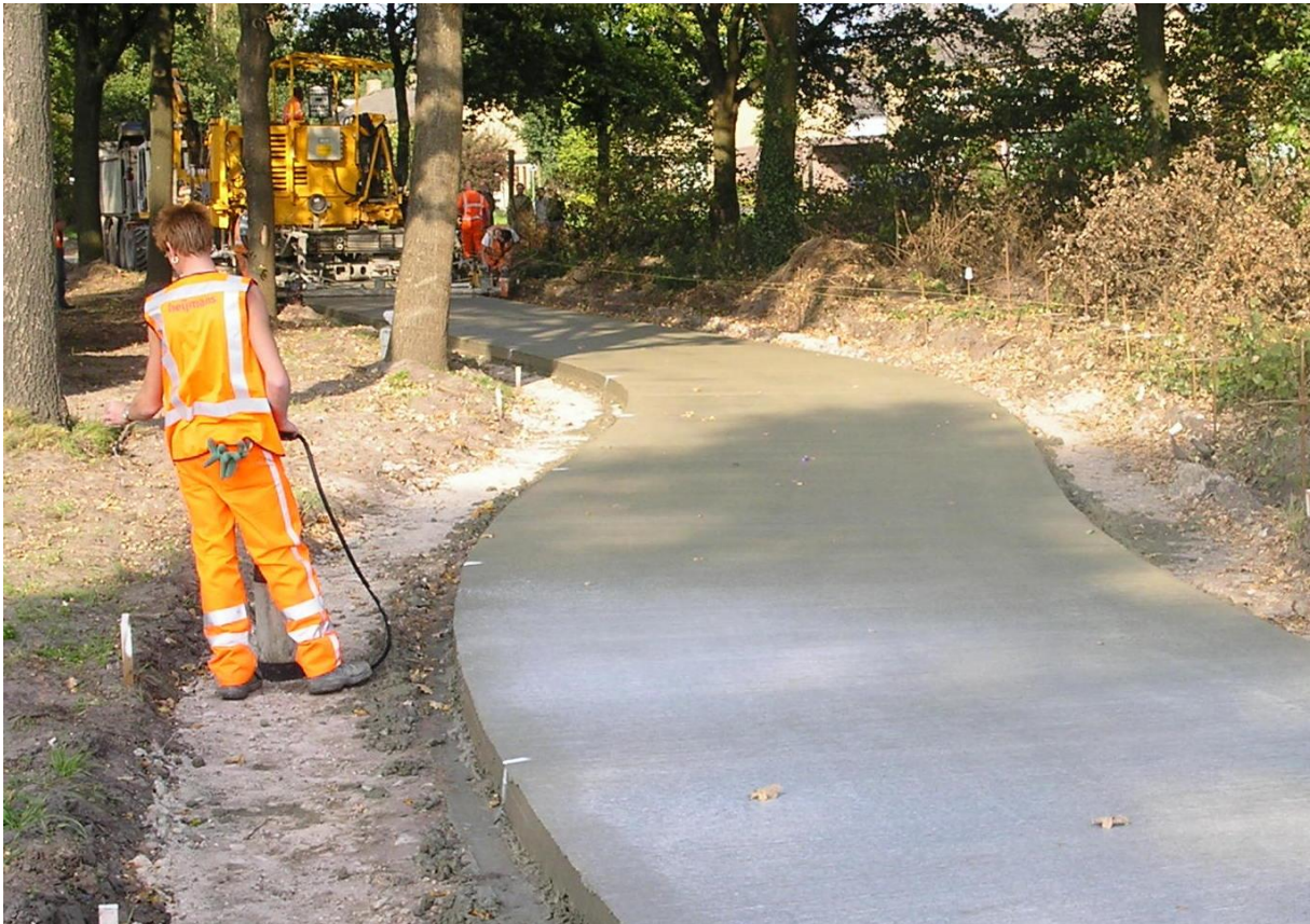
Betonnen fietspad met recyclinggranulaat als toeslagmateriaal
