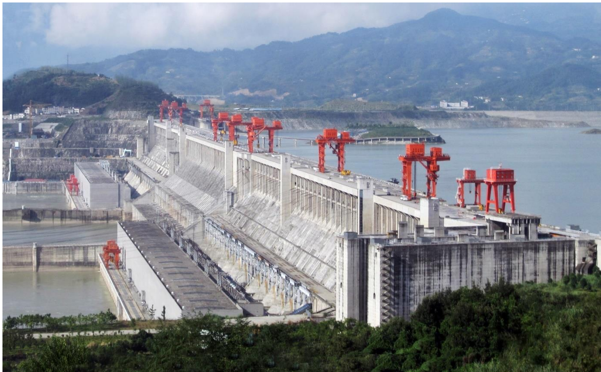
Figuur 2 – in de Drieklovendam in China (1994 – 2006; 2,7 \text{ miljoen m}^3 beton) is belietrijk portlandcement toegepast (bron: Wikimedia Commons)
