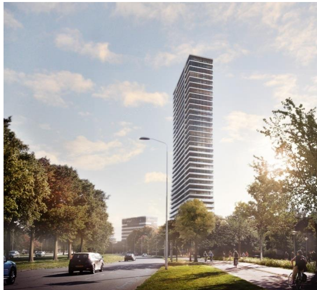
Foto 4 en Fig. 4 De Bunker Toren; een ontwerp van Powerhouse Company in opdracht van RED Company waarin De Bunker de fundering vormt voor de 100 m hoge toren met betonnen draagstructuur
